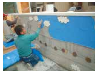
テクノカラーで広い面のコテ塗り
