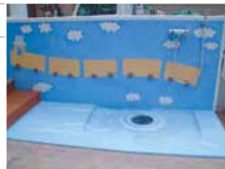
テクノカラー使用部分仕上り
